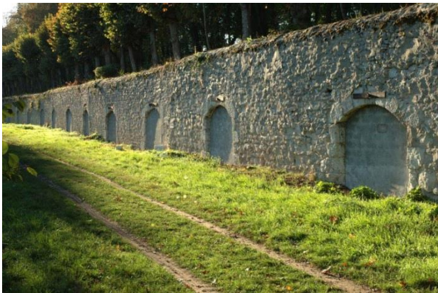
Caves à Meung-sur-Loire, lieu-dit Le Pressoir.
