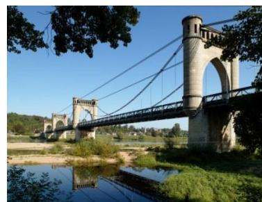
Le pont de Langeais
