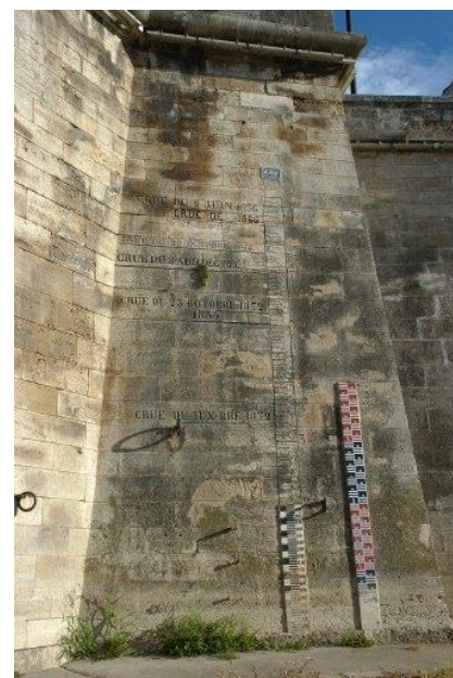
Orléans : échelle de crues, marques de crue et organeaux sur la culée du pont George V, rive droite.
