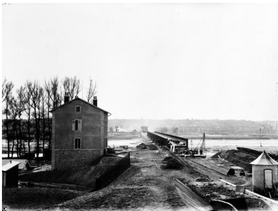
Le chantier du pont-canal vers 1892, musée Nicéphore Niépce, musée de la photographie de Chalon-sur-Saône
