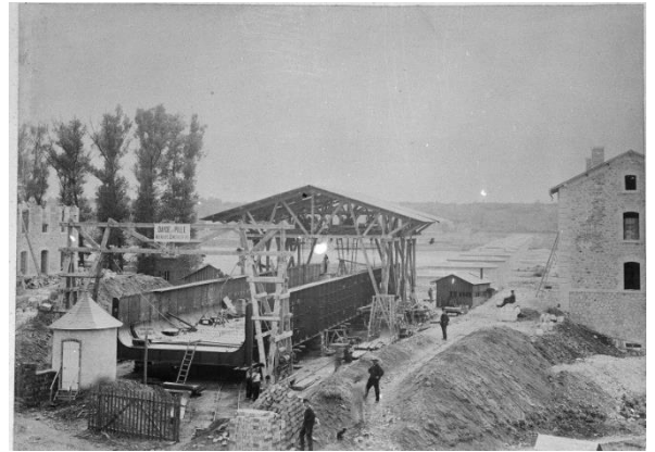
Une travée métallique de 40 mètres avant sa mise en place sur les piles, vers 1892. Document conservé au musée Nicéphore Niépce, musée de la photographie de Chalon-sur-Saône
