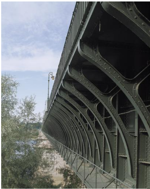
Détail de la structure métallique du pont-canal de Briare
