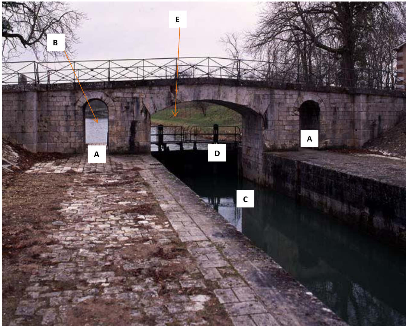
Vue d'une des écluses de Mantelot, à Chatillon-sur-Loire © Région Centre-Val de Loire, Inventaire général, Robert Malnoury
