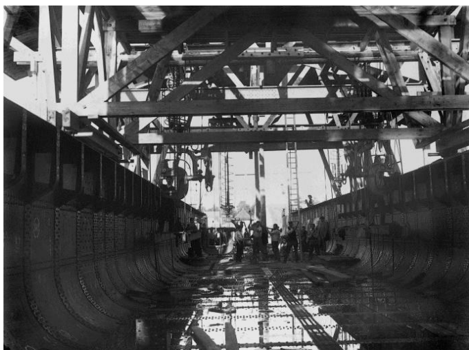
Le chantier vers 1894, document conservé par l'Ecole nationale des ponts et chaussées
