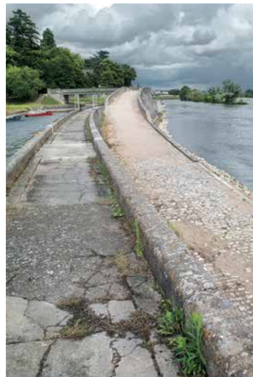
Saint-Jean-de-Braye, cale simple du port de Saint-Loup construite vers 1920.
