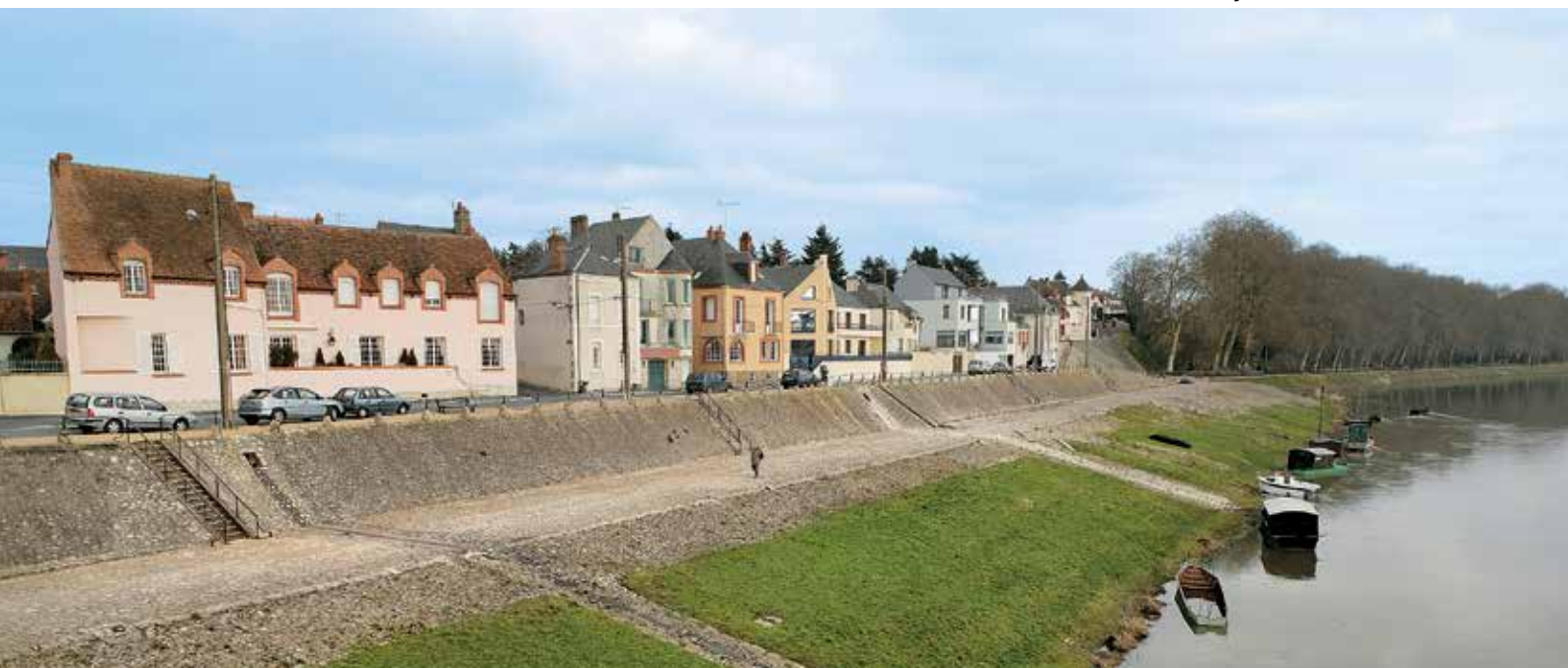
Port de Châteauneuf-sur-Loire
