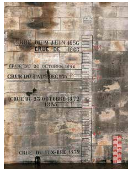
Culée droite du pont Royal à Orléans.
