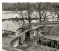
Ecluse de descente en Loire de Mantelot.
