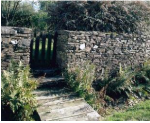
Muro de valla de piedra seca en Préveranges (Cher)
