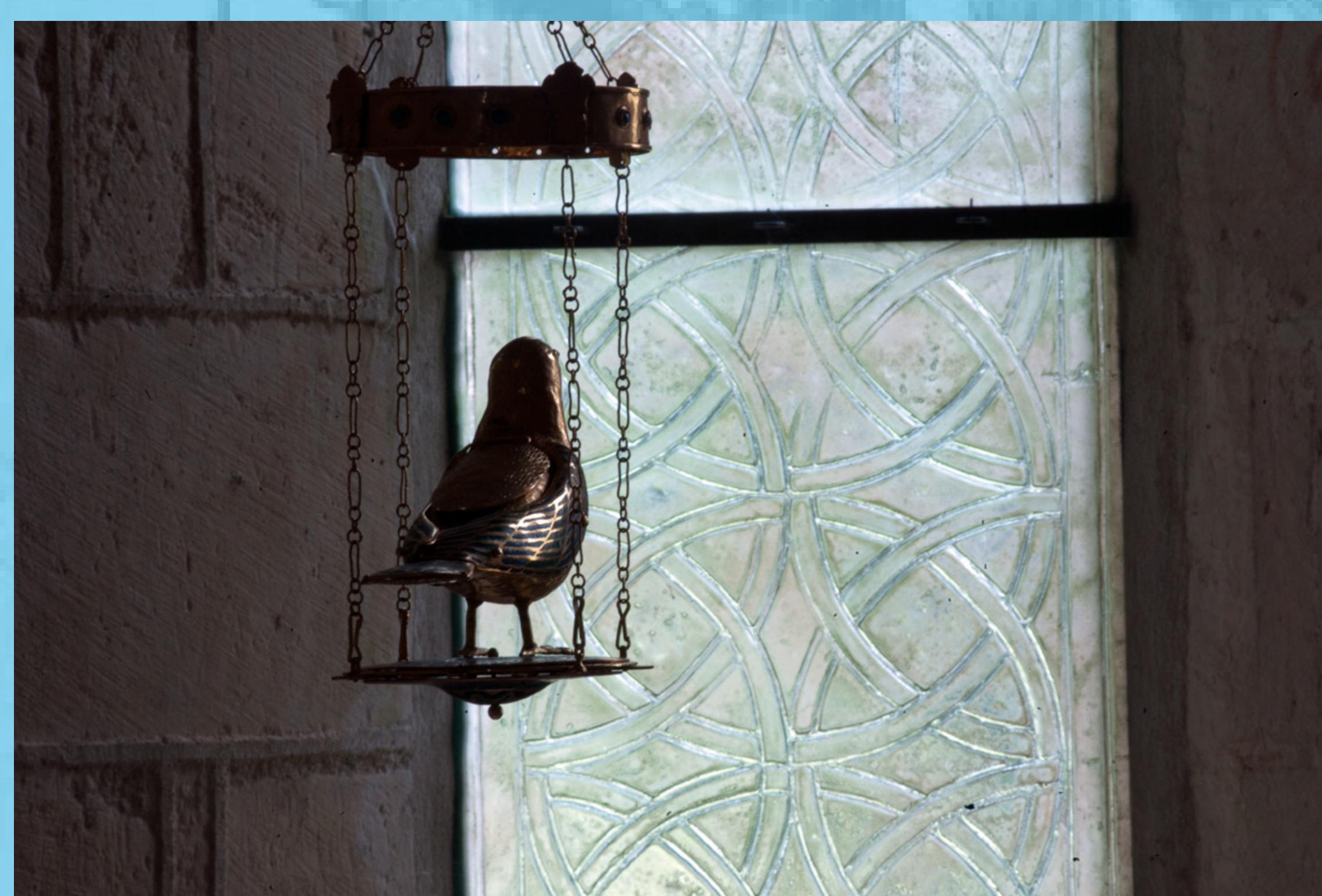
Mérigny, chapelle du prieuré de Puychevrier, Michel Petit, 1998, détail des verrières thermoformées, colorées par un léger dépôt d'oxydes
