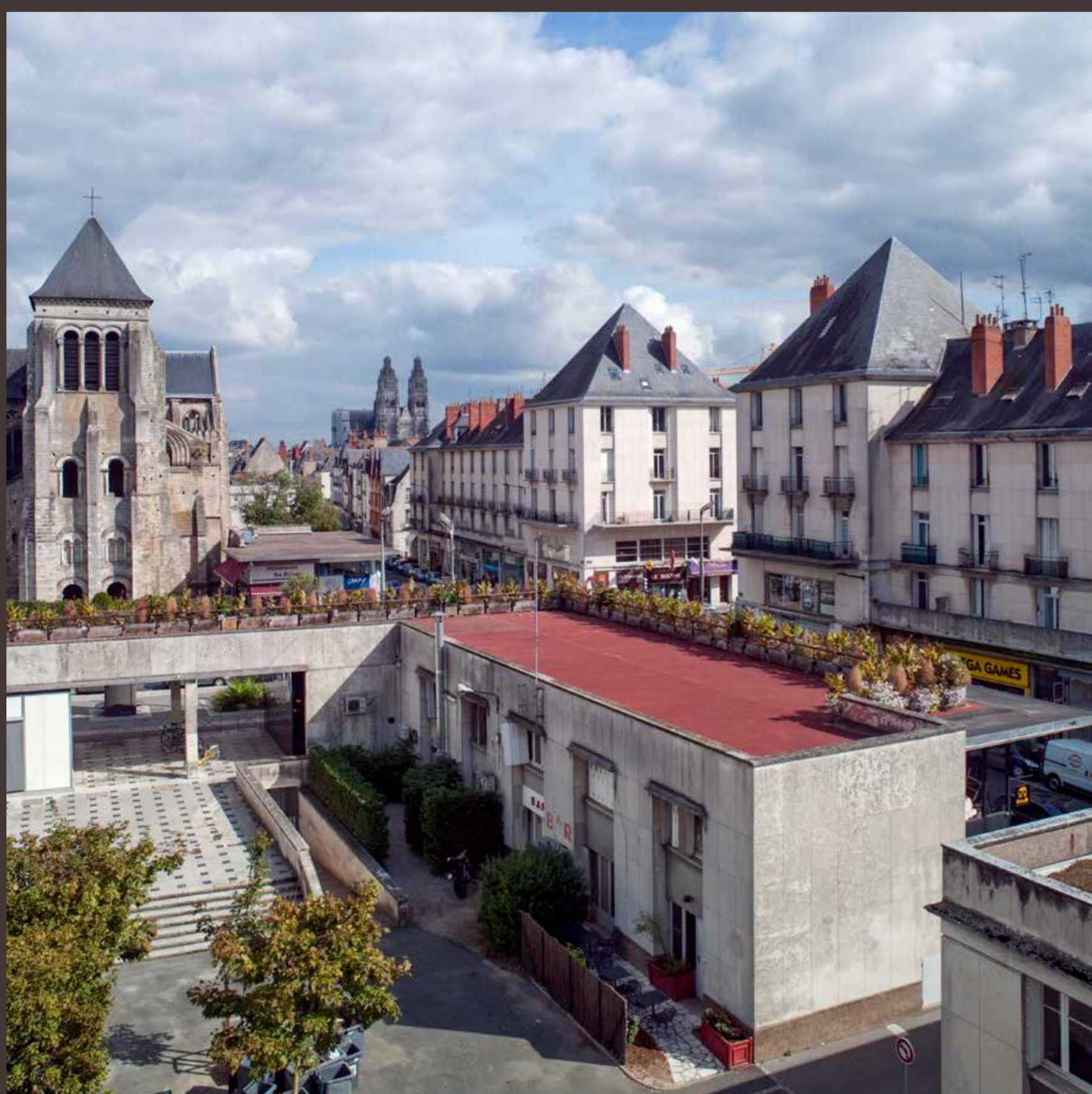
Magasin-terrasse vu depuis l'école des beaux-arts.
