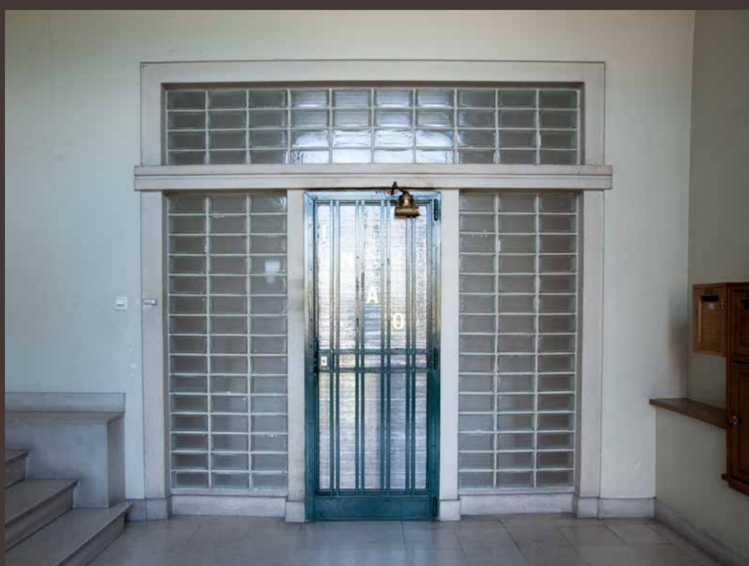
Hall d'immeuble donnant sur une porte en pavés de verre et ferronnerie, îlot V.
