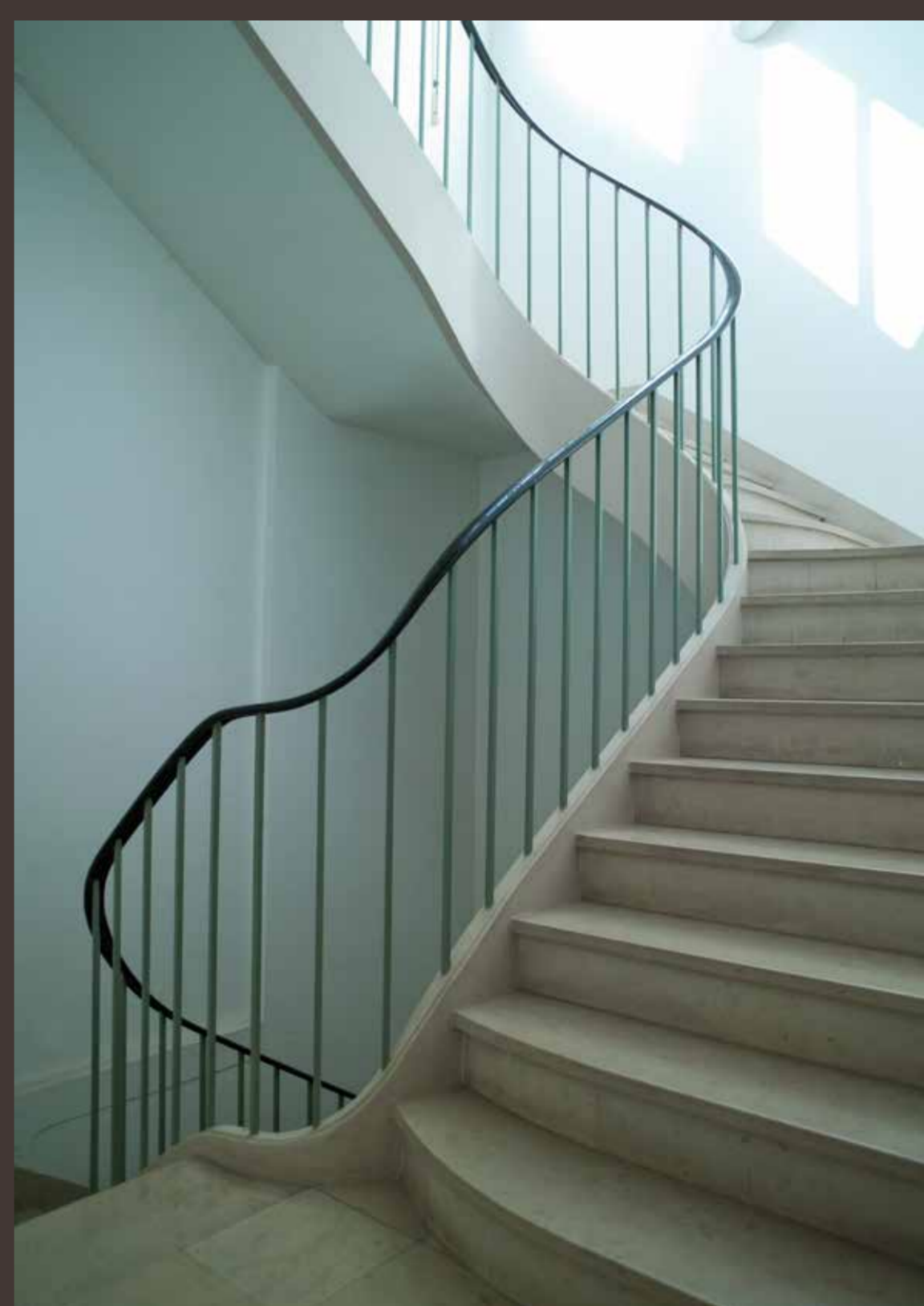
Escalier principal de l'aile est.
