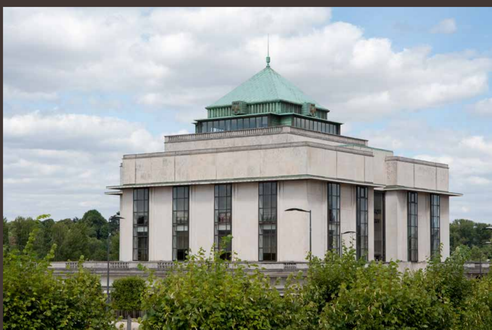
Le toit en pavillon de la bibliothèque.
