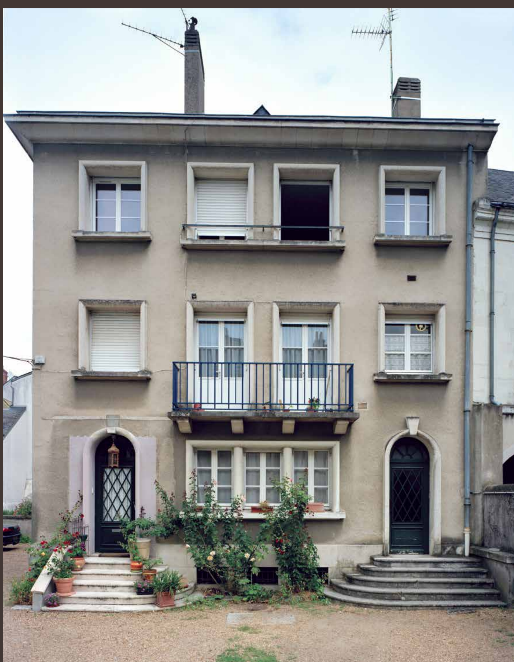
Façade principale de l'ancien commissariat, 14 rue des Amandiers.
