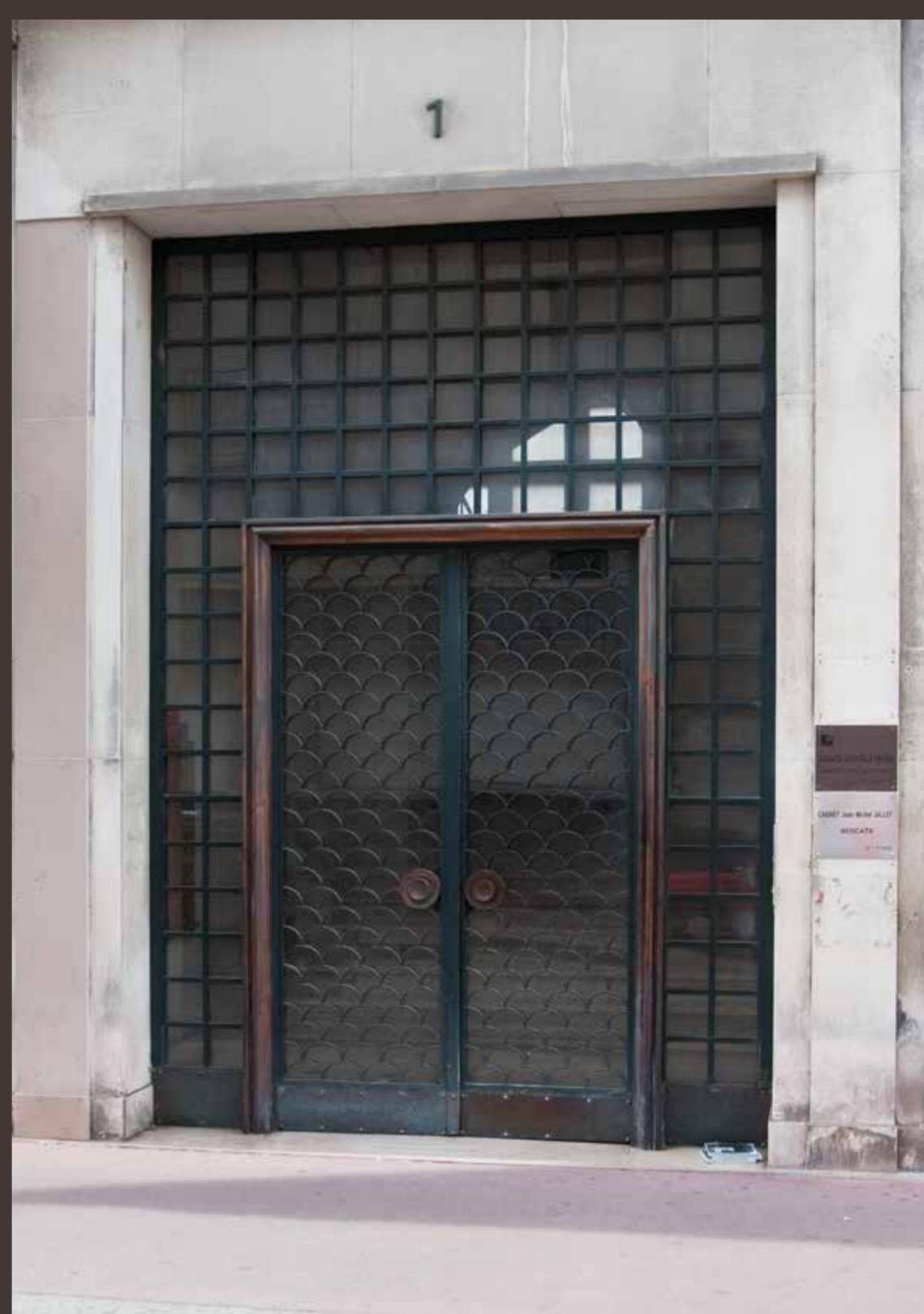
Porte d'entrée du 1 rue du Maréchal-Foch, îlot E.
