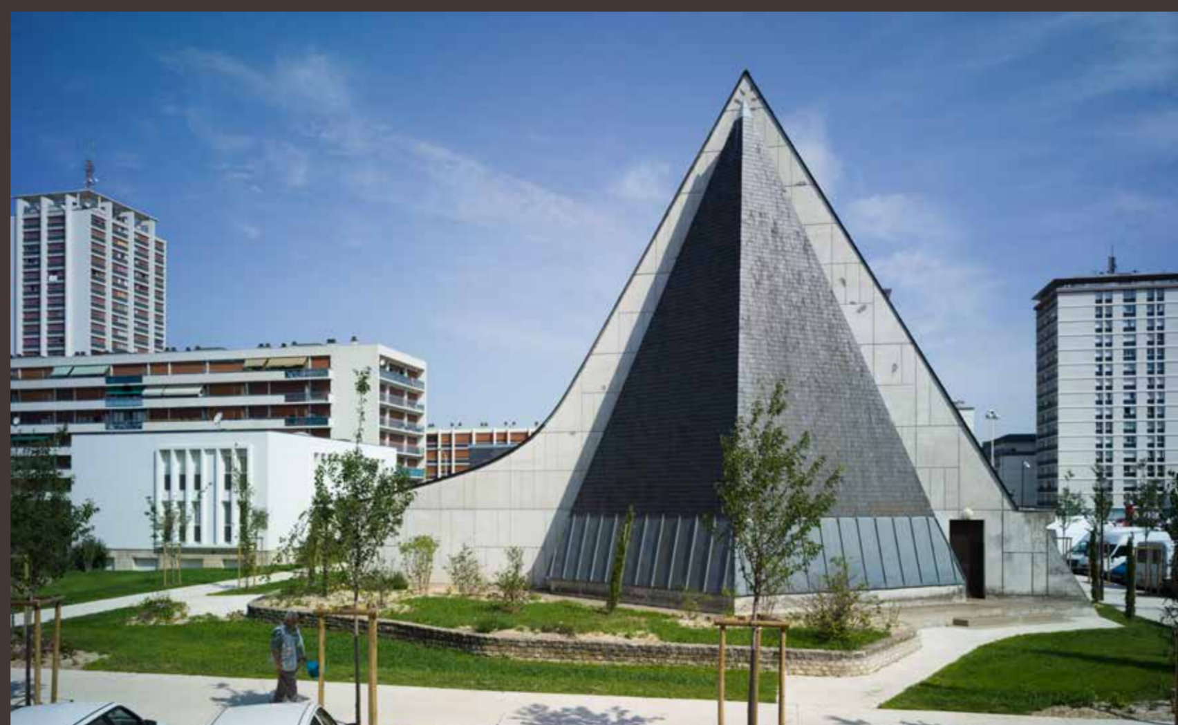
Façade sud de l'église.
